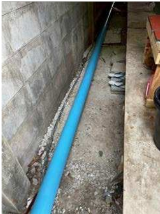
รูปที่ 2-23 ท่อรวบรวมน้ำเสียบริเวณบ้านพักคนงาน
